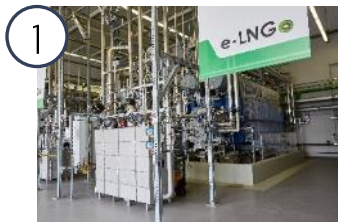
3 Elektrolyseure
